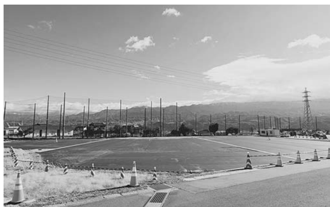
エス・バードの工事の状況 (2026. 1. 8 撮影、講演資料より)
