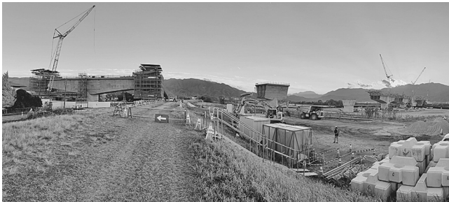
リニア釜無川橋梁工事現場（山梨県中央市、報告書80頁）
