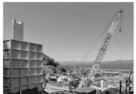
風越山トンネル立坑工事現場 (北条上段) ここからシールドマシンが発進
